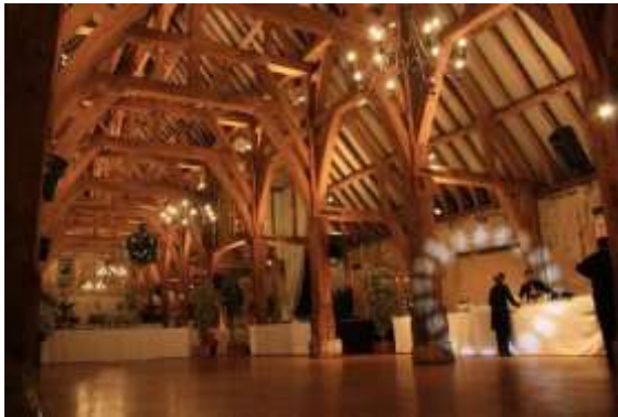
La charpente de l'ancienne grange dimière ...
